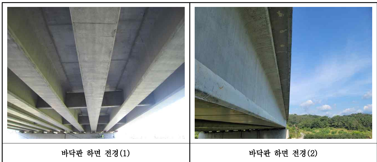
【사진 26.3.2】 바닥판하면 전경
