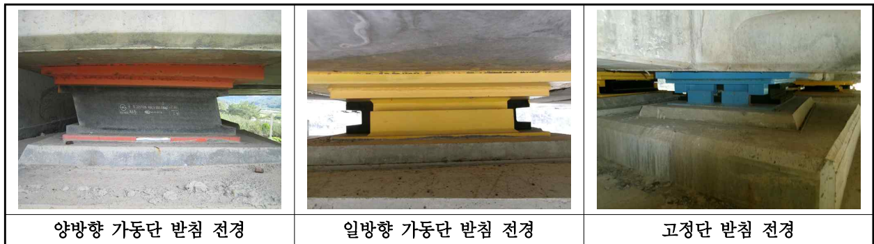
【사진 26.3.37】 교량받침 전경
