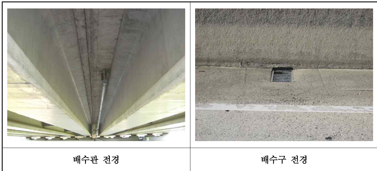
【사진 26.3.21】 배수시설 전경
