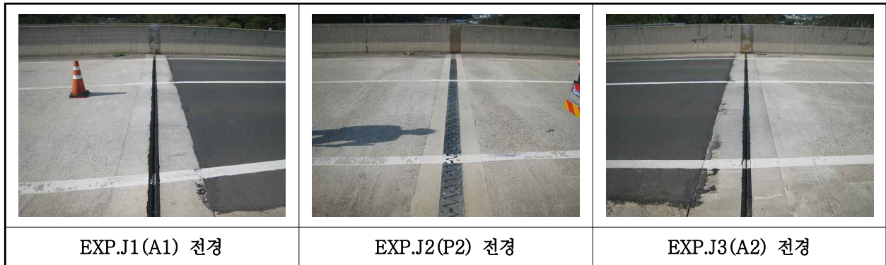
【사진 26.3.16】 신축이음장치 전경
