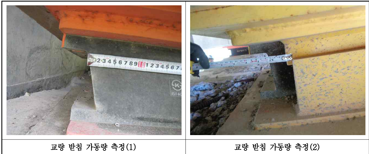
【사진 26.3.40】 교량받침 이동량 측정
