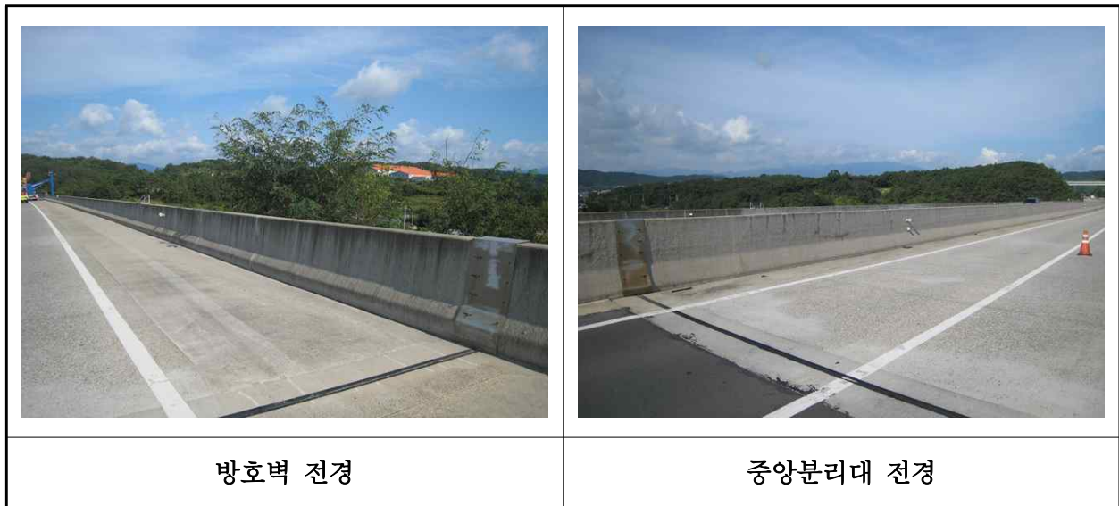
【사진 26.3.23】 방호벽 및 중앙분리대 전경
