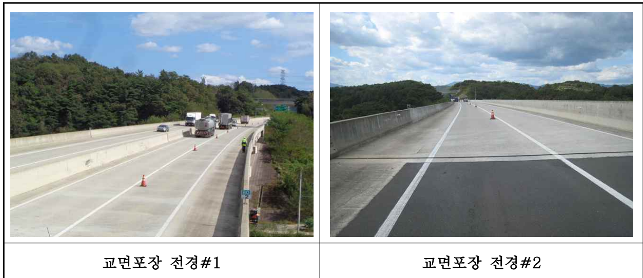
【사진 26.3.44】 교면포장 전경
