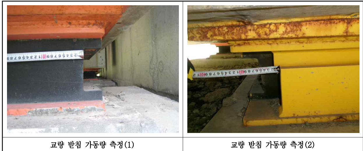
【사진 26.3.15】 교량받침 이동량 측정
