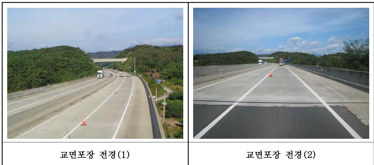
【사진 26.3.19】 교면포장 전경
