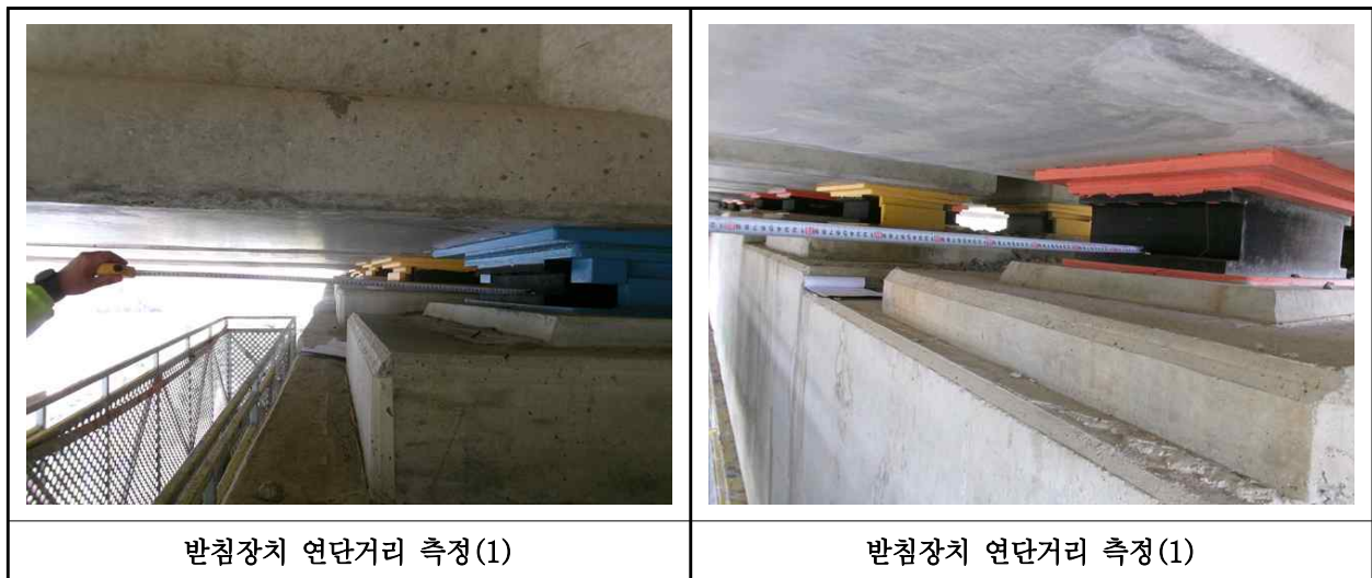
【사진 26.3.39】 교량받침장치 연단거리측정
